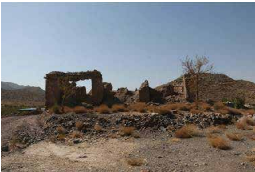
مدرسه تخریب شده مرج
